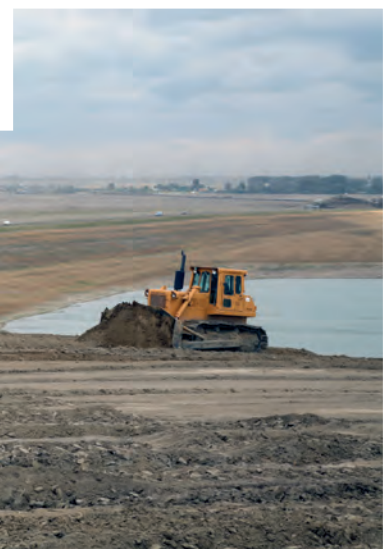
Rekultywacja techniczna zbiornika Malta, 2008 r. (fot. Piotr Ordan)
