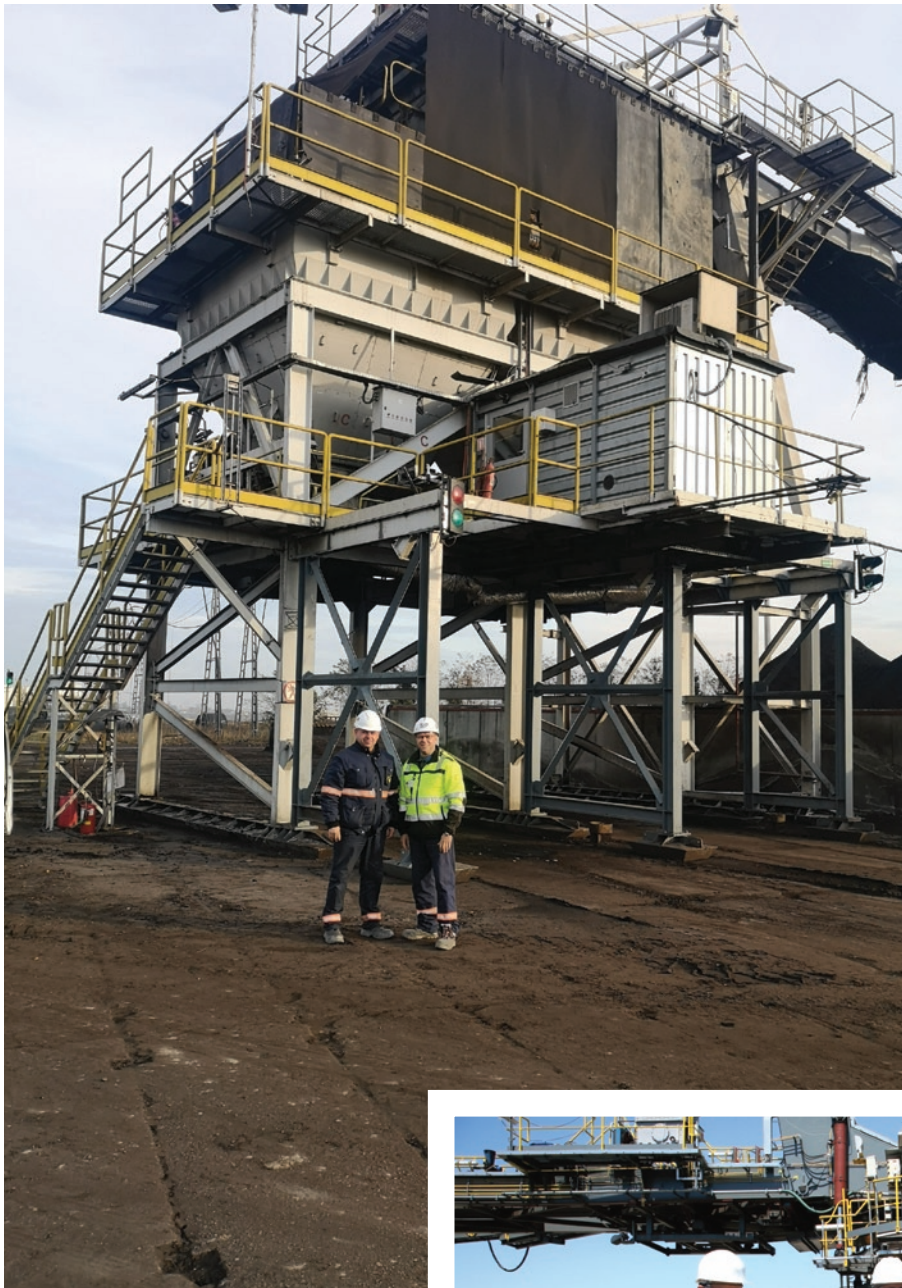
Zmodernizowana załadownia Tomisławice.
