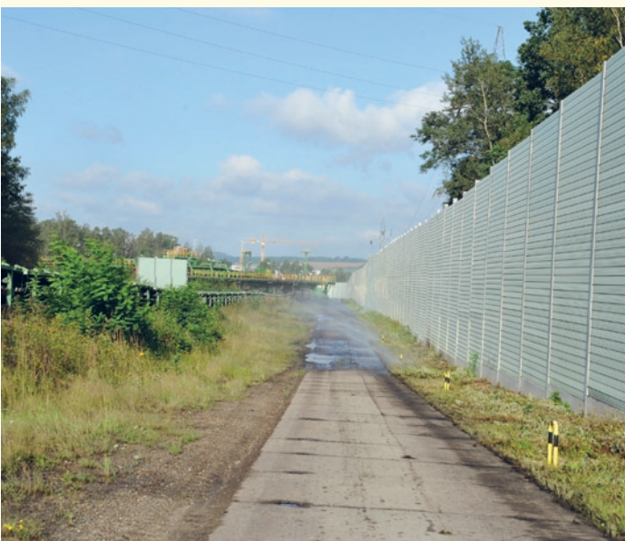
Ekran akustyczny w rejonie zasobnika KWB Turów wraz z wałem akustycznym Zatonie i zraszaniem.
