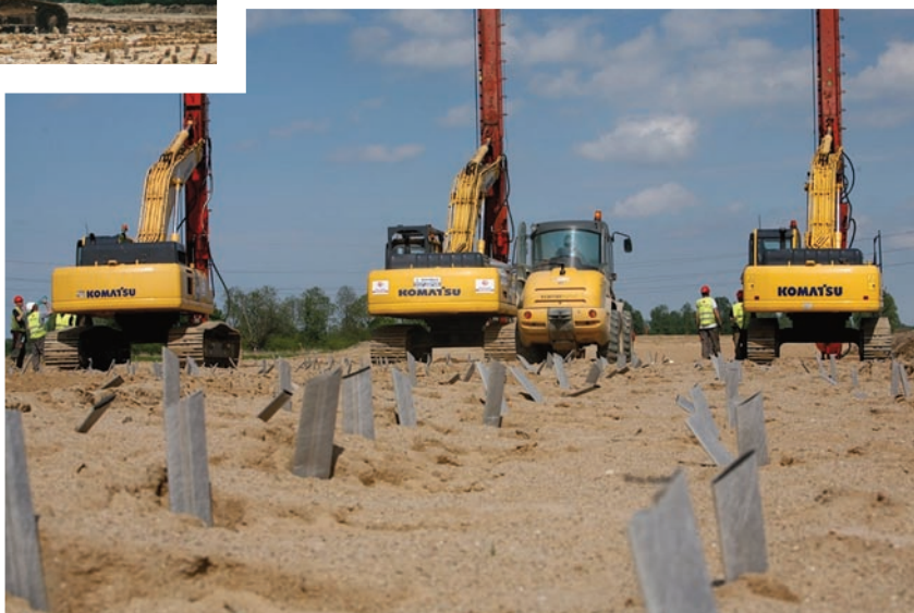
Rys. 2. Montaż PVD. Źródło: materiały otrzymane od Menard Sp. z o.o.
