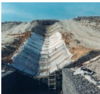
Fot. 2. Sprowadzenie skarpowe wód wykonane z elementów siatkokamiennych (w trakcie budowy i w trakcie eksploatacji).
