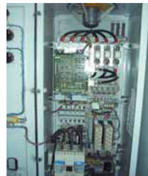
Rys. 3. Tyrystorowy zespół napędowy DML.
