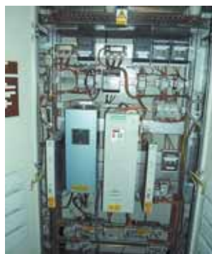
Rys. 4. Kompaktowy przekształtnik częstotliwości zabudowany na koparce.
