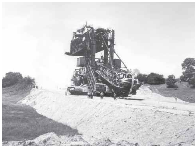
Rys. 5. Przejazd koparki SRs 1200 przez nasyp na kanale Warta-Gopło podczas transportu z „Józwin” na „Lubstów” w 1979 roku.
