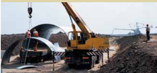
Montaż tunelu z blach karbowanych.
