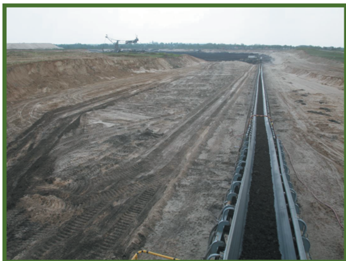
Rys. 5. Pochylnia zjazdowa dla koparek z widocznymi fragmentami zestopniowania skarpy do obniżania przenośników.
