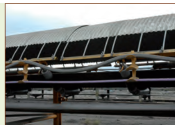
Rys. 17. Widok obudowanego blachą faliastą zbiorniczego przenośnika węglowego.
