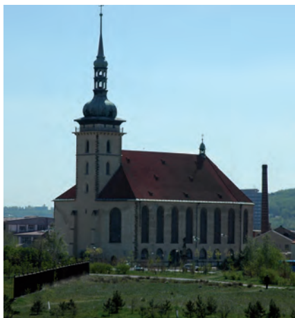
Rys. 25. Kościół Najświętszej Marii Panny przetransportowany w całości w 1975 roku z przedpola kopalni Ležáky.
