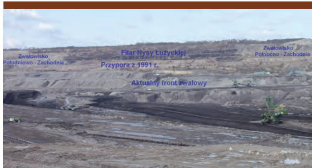
Fot. 2. Stan filara w marcu 2009 roku podparty od spągu +25 wyrobiska do przypory +125.
