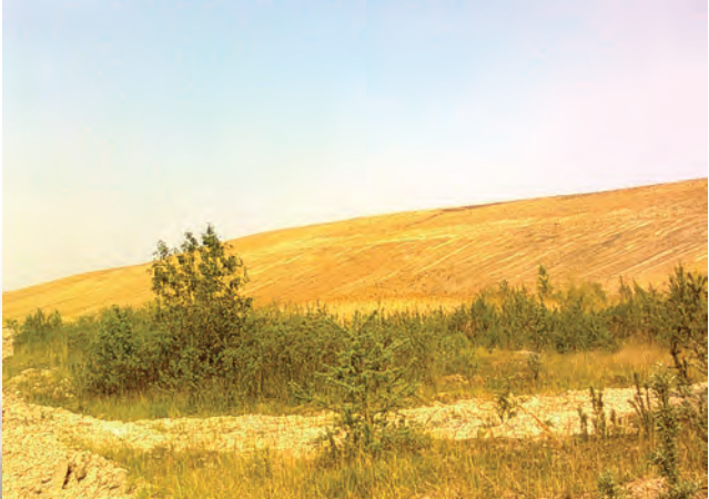
Rys. 4. Widok skarpy wschodniej zbiornika końcowego po wyprofilowaniu – przygotowanie do wykonania obudowy biologicznej (nasadzeń i obsiewów).
