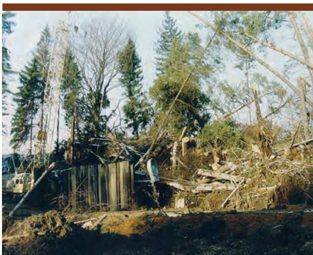
Fot. 4. Postęp jęzora osuwiska na tereny leśne. Budowa ściany oporowej z pali Larsena.
