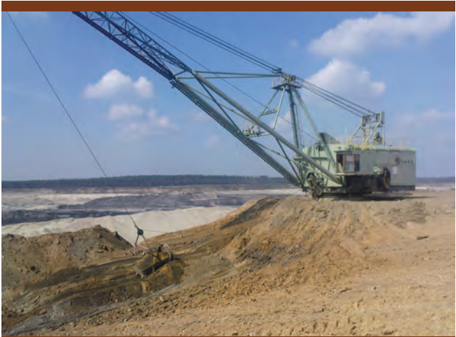
Rys. 3. Profilowanie skarp wyrobiska końcowego odkrywki „Lubstów” koparką zgarniową ESz-6/4,5.
