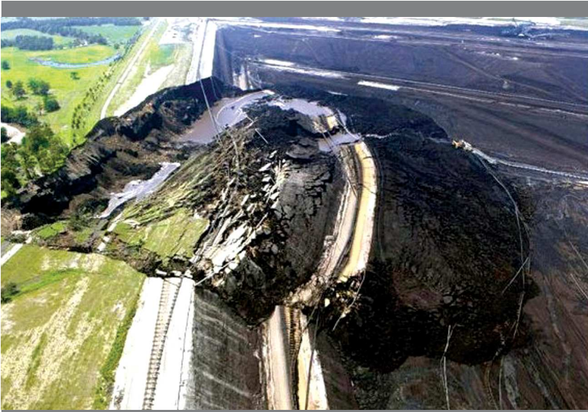
Zdjęcie 1. Osuwisko w likwidowanej kopalni odkrywkowej węgla brunatnego w Saksonii-Anhalt.
