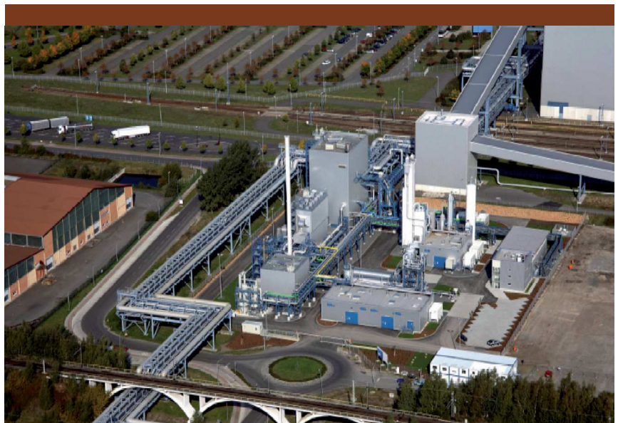
Instalacja pilotażowa elektrowni z CCS o mocy 30 MW, budowanej przy elektrowni w Schwarze Pumpe w Niemczech, 2008 rok.
