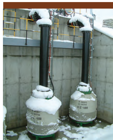
Rys. 21. Pompy OZ posadowione na dnie komory pomp.
