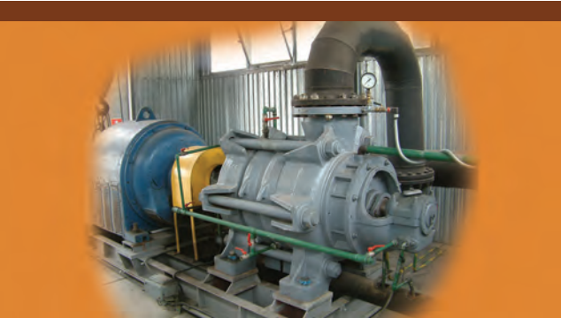
Rys. 15. Agregat pompowy OW-300AM/3.
