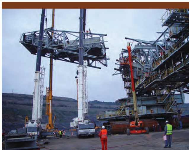
Demontaż przeciwwagi – spektakularna operacja na cztery dźwigi.
