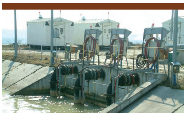
Rys. 22. Pompownia z trzema pompami zatapialnymi OZ-400.
