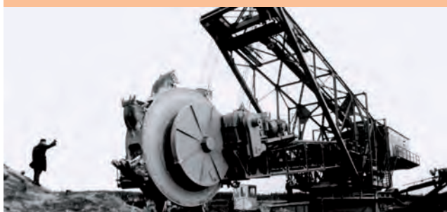
Koparka SchRs-315 urabia pierwsze metry nadkładu w 1963 roku. Maszyna ta wkrótce zostanie eksponatem muzealnym.
