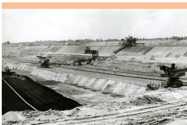
Odkrywka „Kazimierz” w układzie docelowym w 1973 roku. Widać koparkę D-1120, dwa Rs-y 560, na węglu po lewej stronie koparka SchRs-315.
