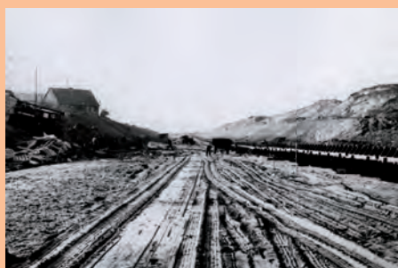
Budowa tras przenośników zwałowania zewnętrznego.
