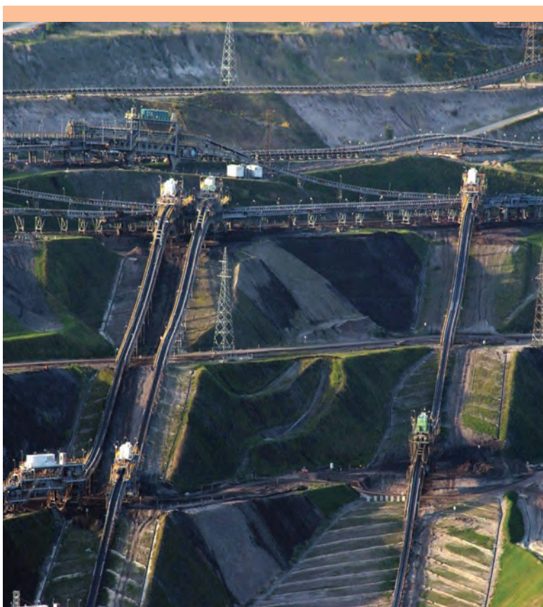
Fot. 1. Rozbudowana sieć transportu przenośnikowego w PGE GiEK S.A. Oddział KWB Bełchatów.
