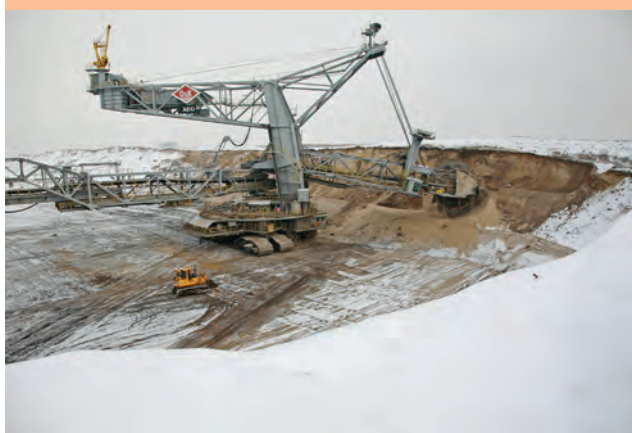
Zimowa sceneria odkrywki „Drzewce”. Na pierwszym poziomie nadkładowym pracuje koparka SchRs-900.
