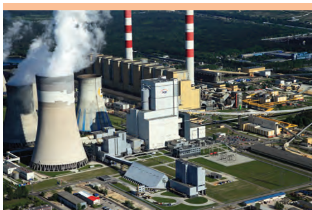
Rys. 10. Elektrownia Bełchatów z blokiem 858 MW [Fot. El. Bełchatów].
