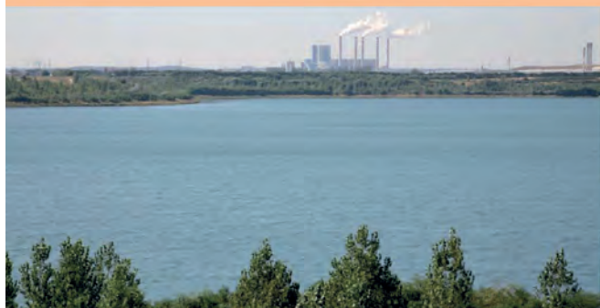
Rys. 2. Panorama zbiornika wodnego po odkrywcze „Pątnów” w Kopalni „Konin”; powierzchnia ponad 350 ha i pojemności ok. 85 mln m 3 wody [Fot. P. Ordan, KWB „Konin”].
