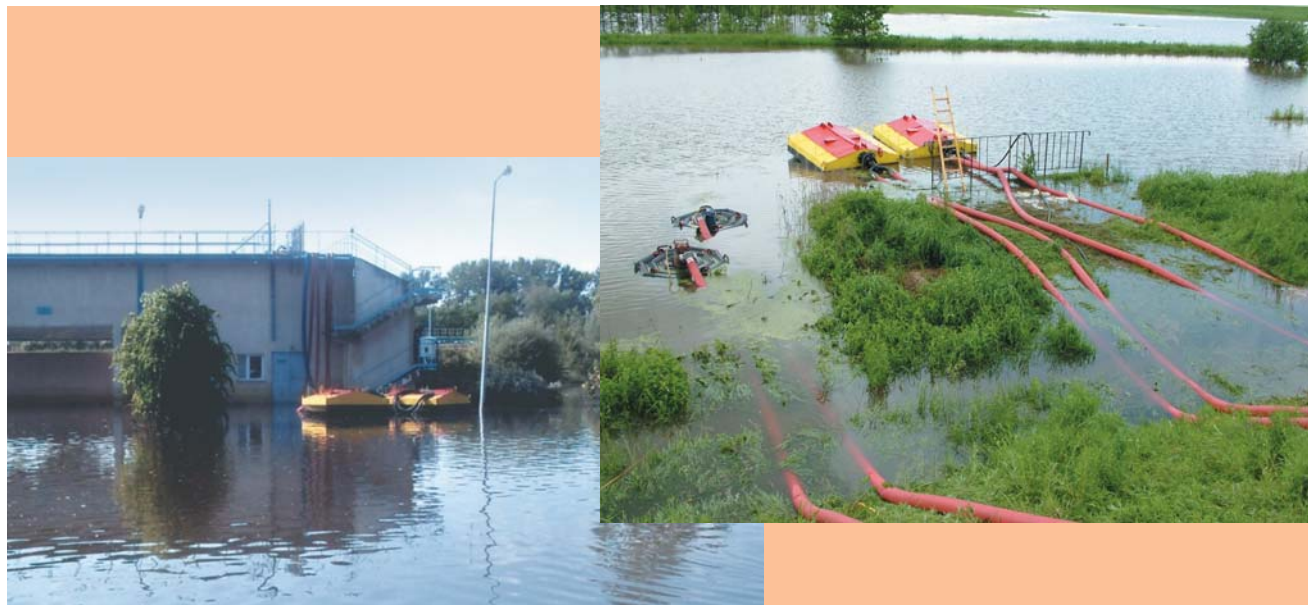
Fot. 30. Stanowiska pompowe z pompami ON-200BB/P podczas akcji popowodziowych w okolicach Baranowa Sandomierskiego.
