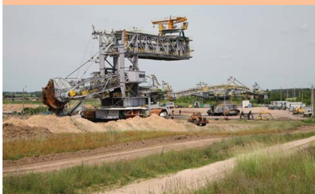
SRs-1200 wyjeżdża z placu montażowego.
