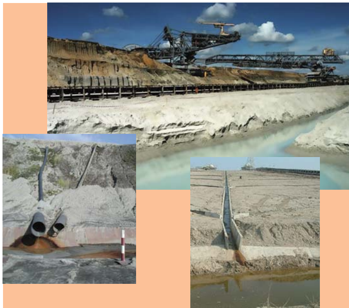
Fot. 2. Obiekty odwodnienia powierzchniowego w wyrobisku.
