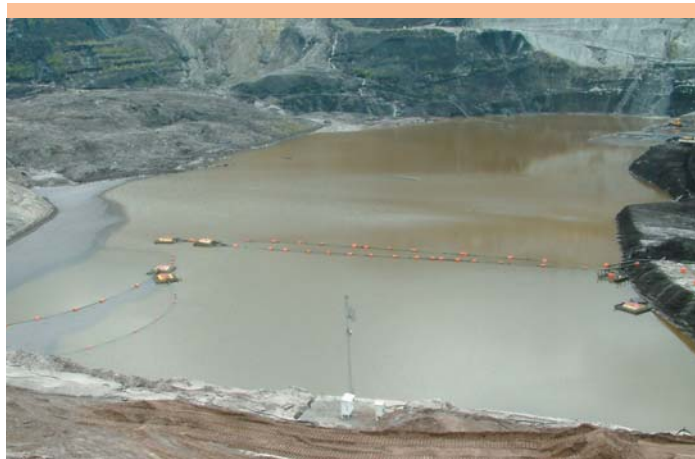
Fot. 26. Pontony z pompami monoblokowymi PJM i ON-200 na poziomie -90 m n.p.m.
