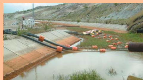
Fot. 15. Stanowisko pompowe w zbiorniku stałym zlikwidowanej pompowni Q_n=3 \times 500 \text{ m}^3/\text{h} , H_n=77 \text{ m} .
