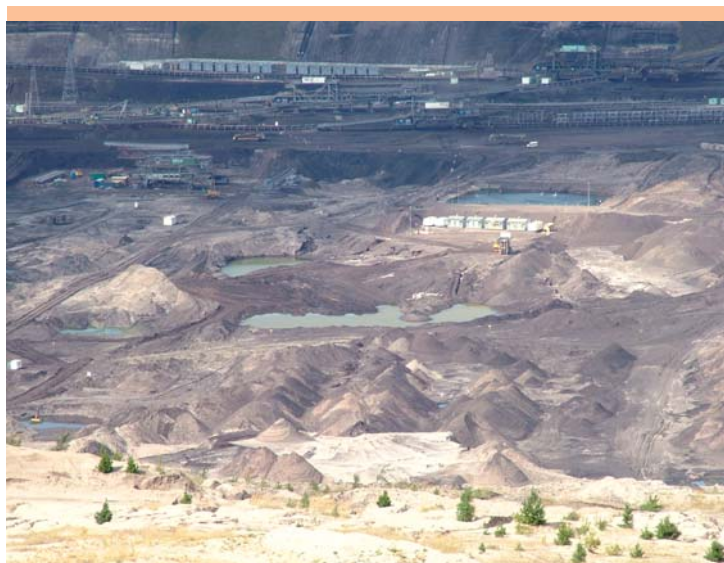
Fot. 1. Obiekty odwodnienia powierzchniowego na spągu wyrobiska.
