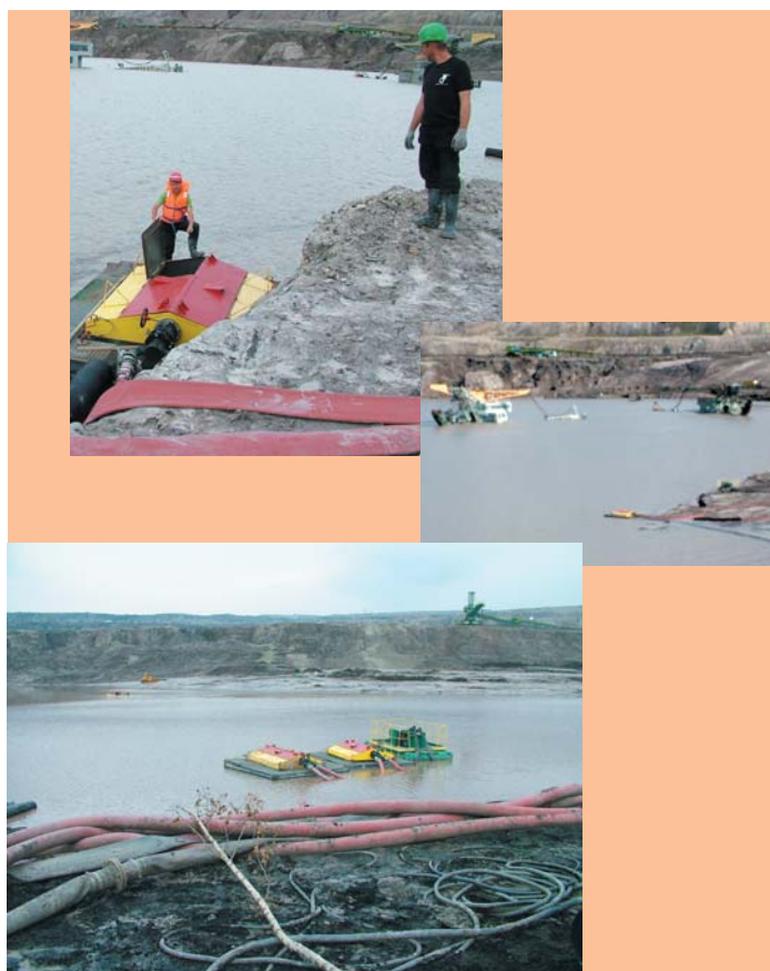
Fot. 31. Stanowiska pompowe z pompami ON-200FB/S podczas akcji popowodziowej w KWB Turów.
