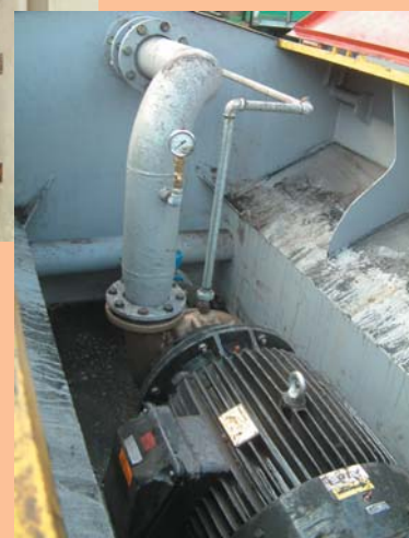
Fot. 12. Pompa monoblokowa typu PJM w układzie pompowym jak na fot. 11.
