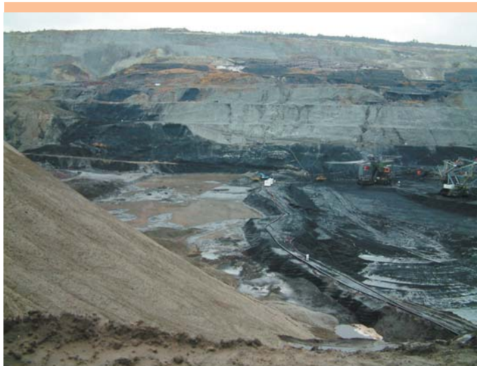
Fot. 28. Zakończenie pompowania zespołem pompowym do hydrotransportu PH-250/570 z poz. -110 m n.p.m. na poz. -30 m n.p.m.
