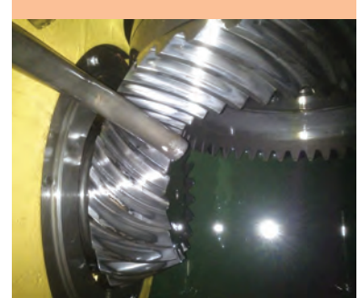
Inspekcja przekładni napędu łańcucha koparki K-74 – oględziny stanu zazębienia.
