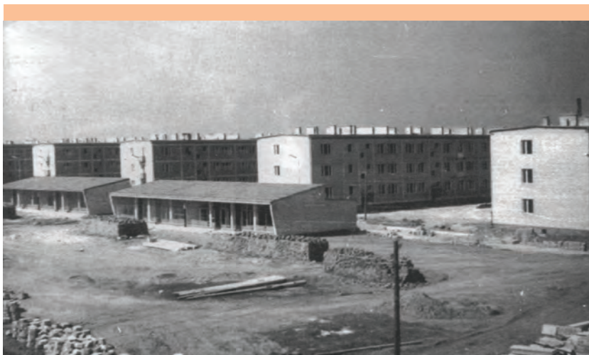
Budowa osiedla dla górników.
