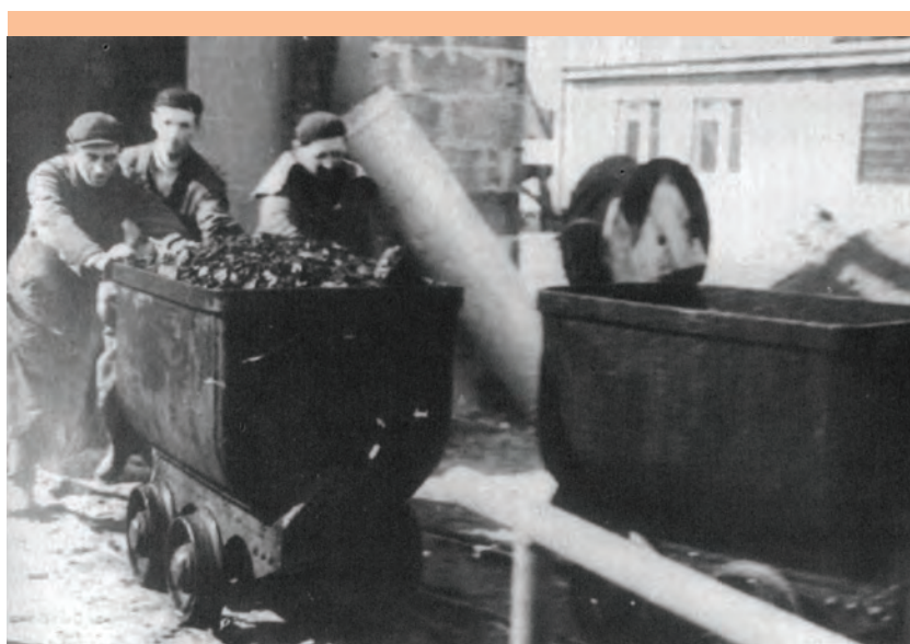
Transport węgla z chodnika odwadniającego (początek lat 60-tych).
