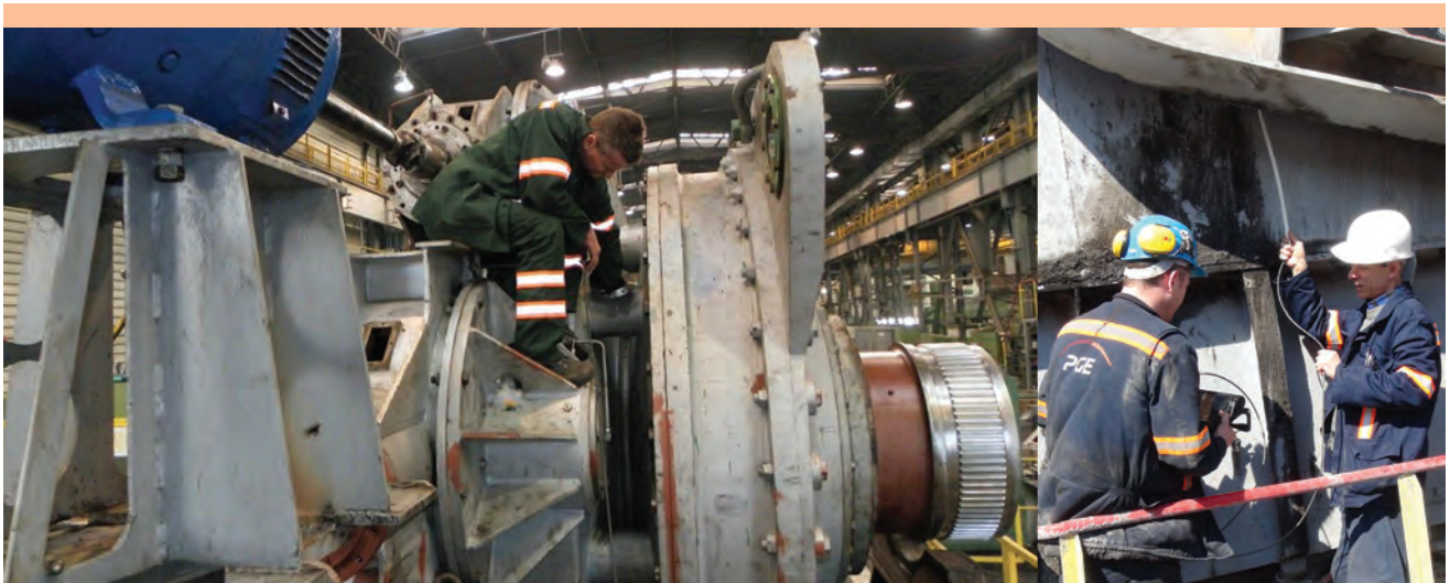
Oględziny zazębień przekładni głównej koła czepakowego za pomocą wideoskoku podczas kontroli na stacji prób i w terenie na obiekcie.
