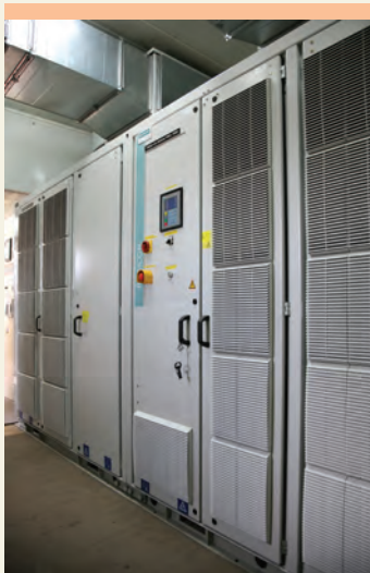
Przełączniki częstotliwości w rozdzielni 1X6.
