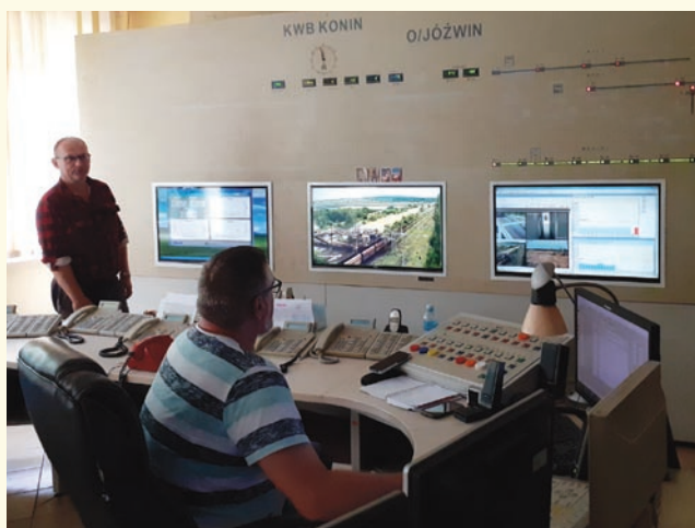
Dyspozytornia odkrywki Józwin w lipcu 2022 roku.
