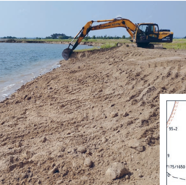
Profilowanie skarpy w strefie nadwodnej.
