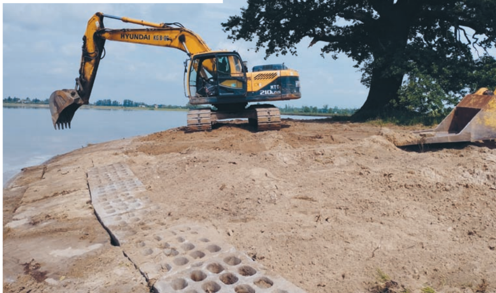
Odbudowa i umocnienie skarpy przy użyciu elementów betonowych.
